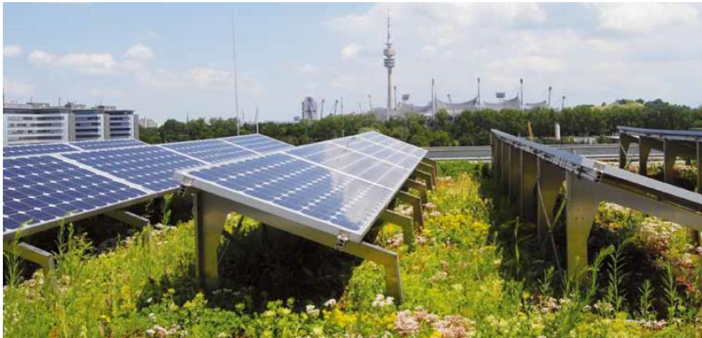
Abbildung 1: Fotovoltaik-Gründachanlage, © Optigrün
