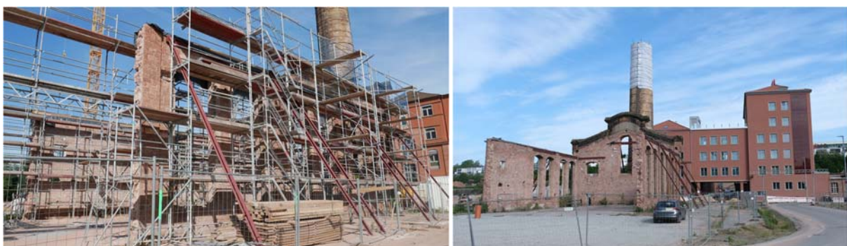
Abbildung 6: Resthülle des Neuen Kesselhauses nach Einstellung der Baustelle im Juni 2021 (links) sowie im Mai 2025 (rechts) Quelle: EnStadt:Pfaff / Fraunhofer ISE
