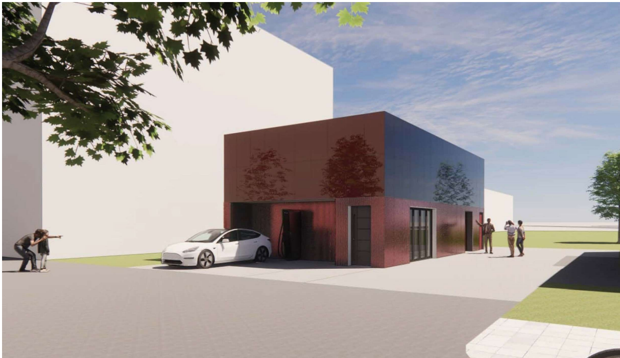
Abbildung 2: Rendering der Energiezentrale im Pfaff-Quartier, Darstellung der Südost- und Südwest-Fassade, die in der oberen Hälfte als PV-Fassade ausgeführt wird, Quelle: RBS wave
