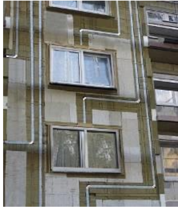
b) Installierte wandnahe 80 mm Dämmschicht mit den integrierten Leitungen vor der Installation der äußeren 80 mm Dämmschicht.
