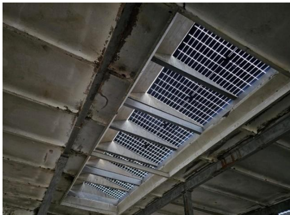
Abbildung 7: Semitransparente Lichtkuppeln auf der Garage
