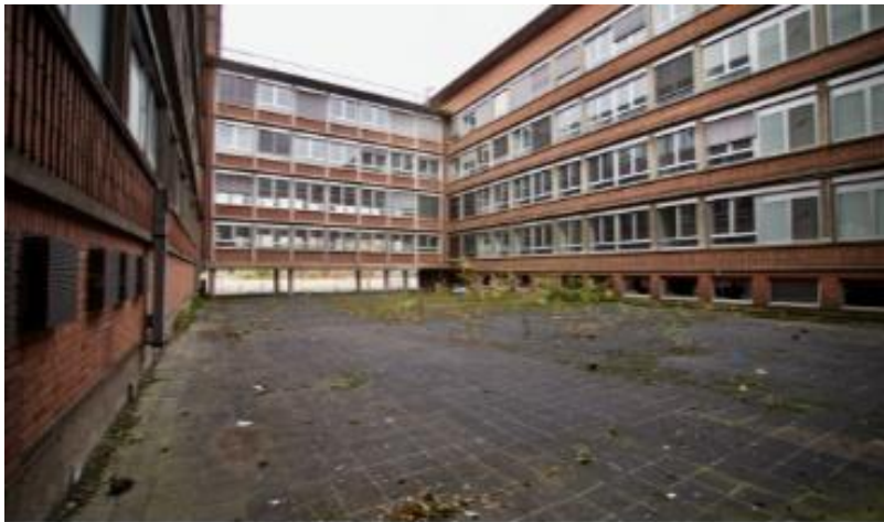
Abbildung 9: Neues Verwaltungsgebäude mit Innenhof
