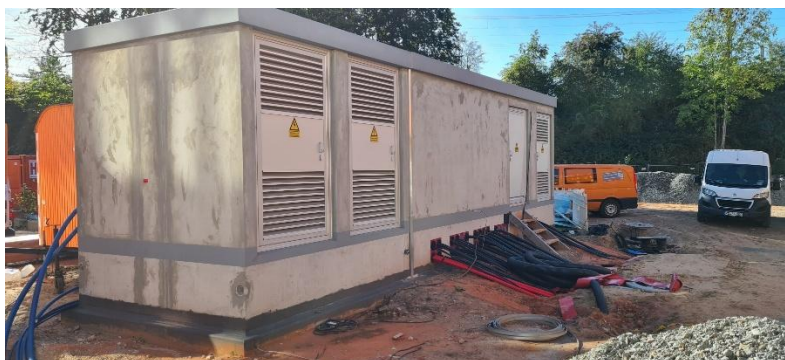
Abbildung 14: Regelbarer Ortsnetztransformator MVZ
