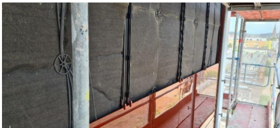
Abbildung 5: Dach- und Fassadenintegrierte rote PV-Anlagen
