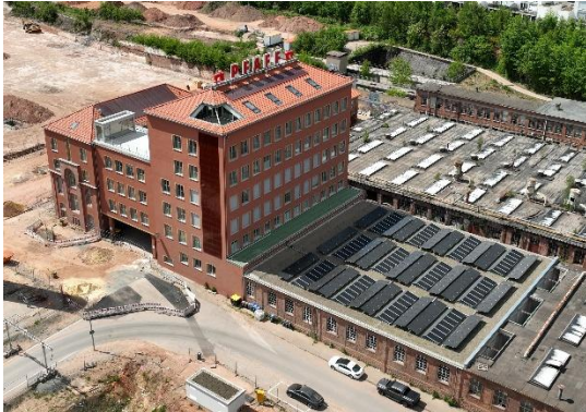
Abbildung 4: Dach- und Fassadenintegrierte rote PV-Anlagen
