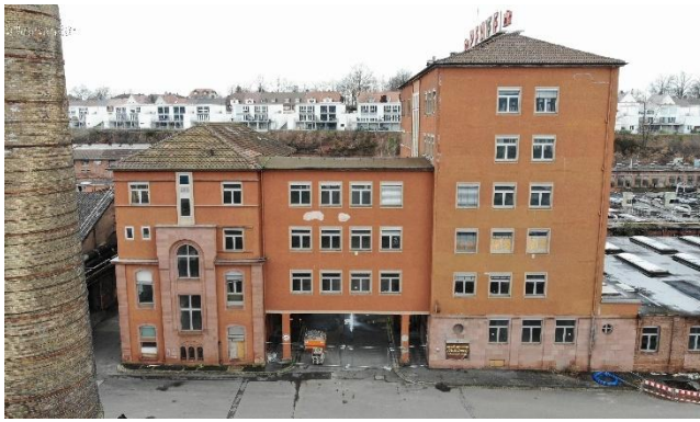
Abbildung 2: Altes Verwaltungsgebäude mit den Gebäudeteilen A, B und C (von links)
