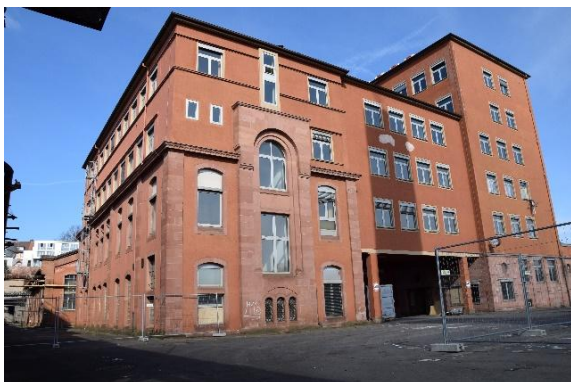
Abbildung 1: Altes Verwaltungsgebäude mit den Gebäudeteilen A, B und C (von links)
