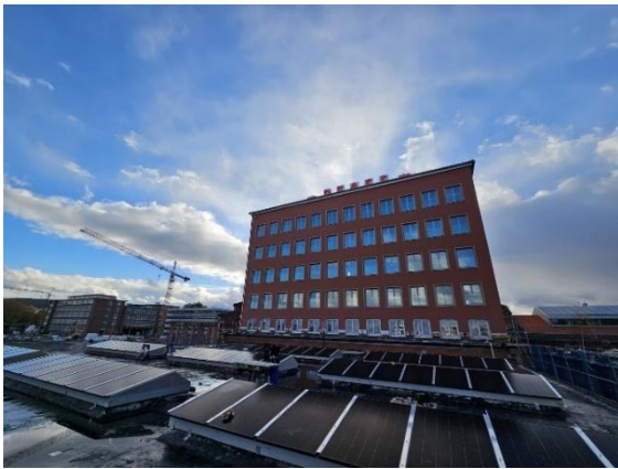
Abbildung 6: Semitransparente Lichtkuppeln auf der Garage
