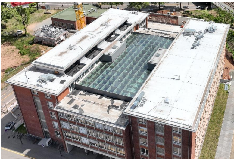
Abbildung 10: MVZ mit überdachtem Innenhof
