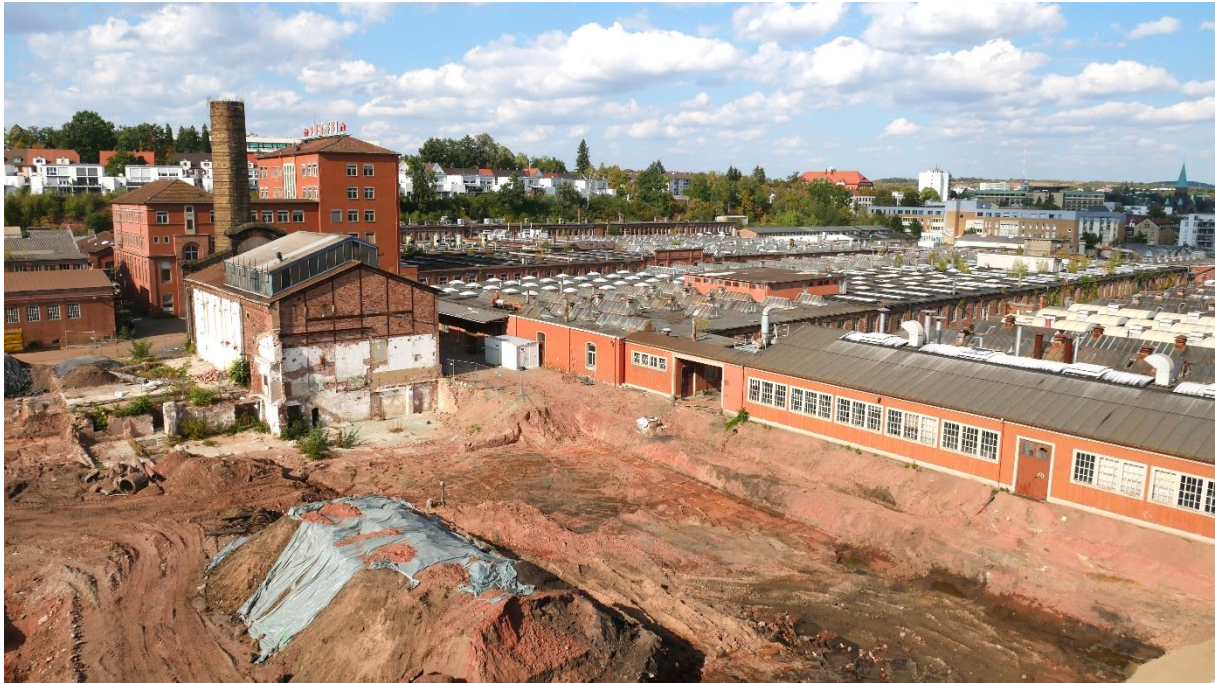
Abbildung I-1: Pfaff-Gelände mit neuem Kesselhaus (Mitte), altem Verwaltungsgebäude (dahinter) und den einstöckigen Produktionsgebäuden (rechts), vorne ist Bodenaushub zur Bodensanierung zu sehen (September 2020) – © EnStadt:Pfaff / ISE
