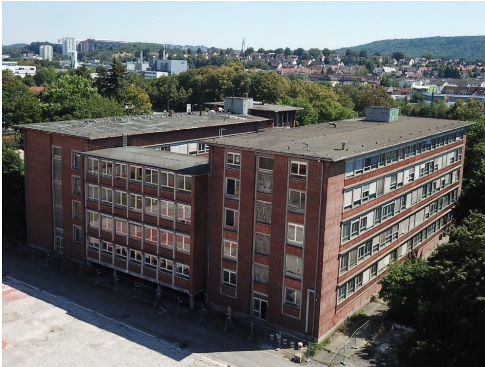
Abbildung II-34: Luftaufnahme des neuen Verwaltungsgebäudes, Ansicht West - © IfaS
