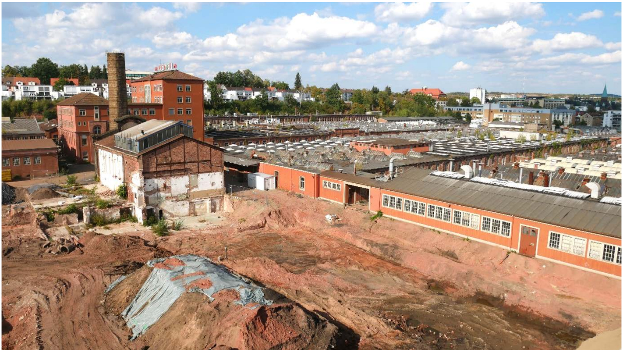
Abb. 1: Pfaff-Gelände mit neuem Kesselhaus (Mitte), altem Verwaltungsgebäude (dahinter) und den einstöckigen Produktionsgebäuden (rechts), vorne ist Bodenaushub zur Bodensanierung zu sehen (September 2020), Quelle: EnStadt: Pfaff / ISE
