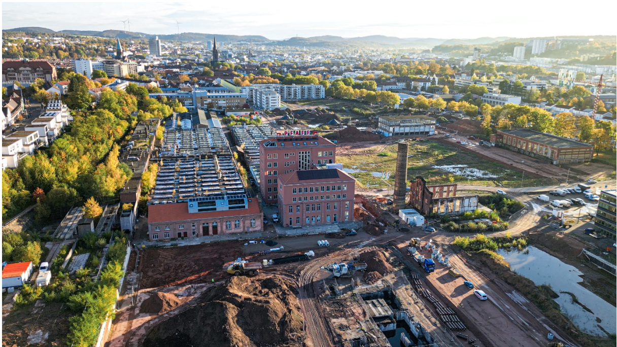
Abb. 5: Luftbild des Pfaff-Quartiers mit dem sanierten alten Verwaltungsgebäude (Mitte) und dem alten Kesselhaus (links) und dahinter liegenden ehemaligen einstöckigen Produktionsgebäuden, die Flächen unten und Mitte rechts wurden saniert und werden für die Vermarktung erschlossen (Oktober 2024), Quelle: Triolog / EnStadt:Pfaff
