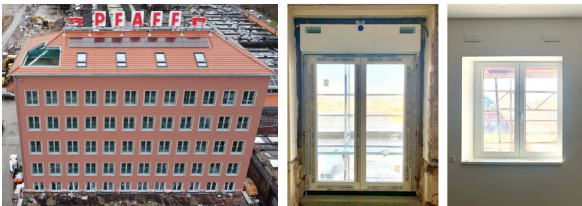
Abbildung 11: Nord-Ost Fassade des Alten Verwaltungsgebäudes (links), Fensterrahmen-integriertes Lüftungsgerät in der Einbausituation (Mitte) und die Innenansicht eines eingebauten Geräts (rechts), Quelle: Fraunhofer ISE
