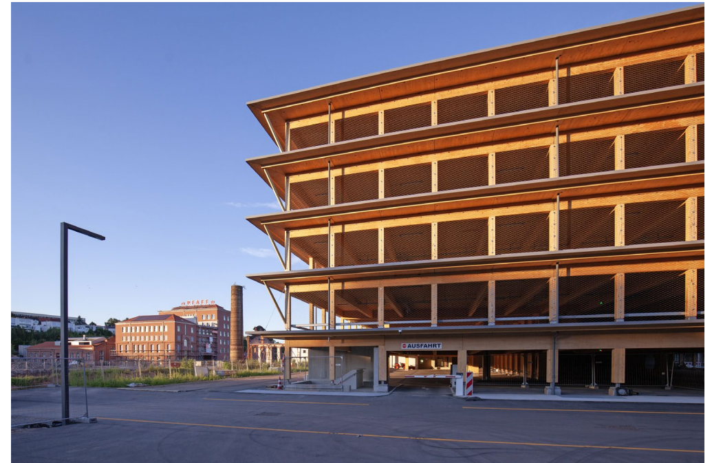
Parkhaus in Holzkonstruktion auf dem Pfaff-Gelände: Reduzierte Graue Energie und gute Recyclebarkeit
