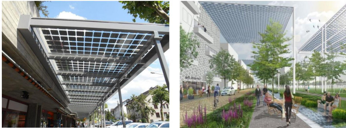
Abbildung 8: Beispiele für Solarintegration: PV-Fußweg-Überdachung (links) und Fußweg-Überdachung in Gebäudehöhe (rechts) (Wüllner und Meyer 2018, S. 16)
